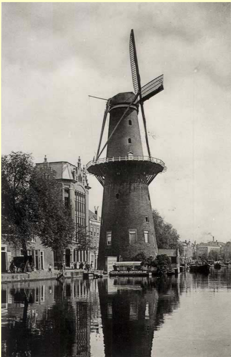
Het accumulatorenstation A aan de Coolvest (het hoge gebouw naast de molen) voorzorg de rechter Maasoever van elektriciteit. Bron: Siemens & Halske Aktiengesellschaft, Elektrische Central-Anlagen, deel 1 (Berlin 1900).
