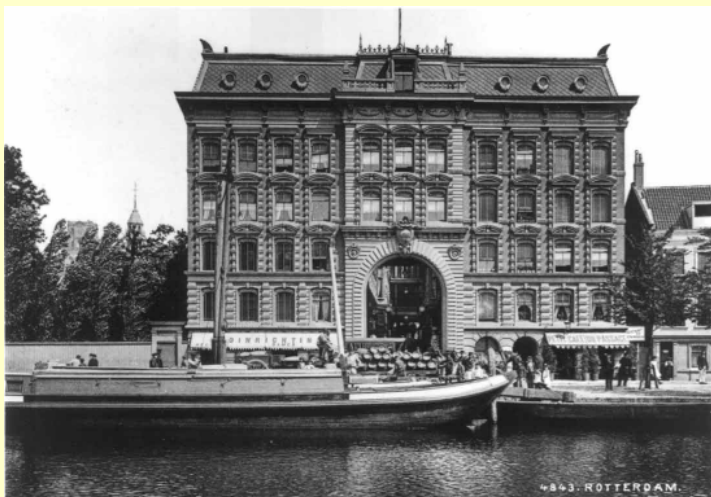
De winkelpassage aan de Coolvest was vermoedelijk het eerste object in Nederland, dat vanuit een centrale werd verlicht (1883). Bron: Gemeentearchief Rotterdam.
