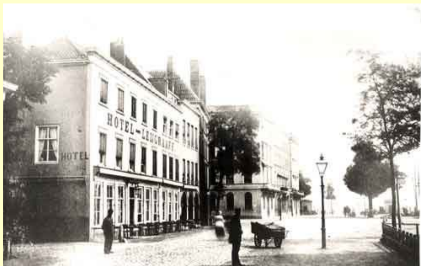
Hotel Leygraaff aan het Westplein in Rotterdam was al in 1878 in het bezit van een eigen elektrische installatie. Bron: Gemeentearchief Rotterdam.
