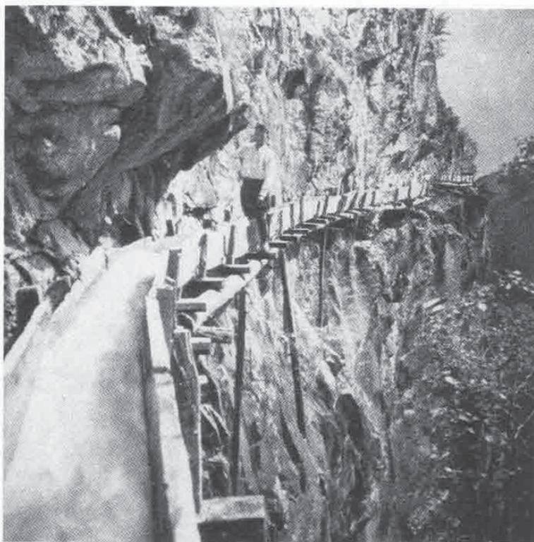
Afb. 4. Irrigatiekanaal "Torrent Neuf" bij Saviese / Sion.
