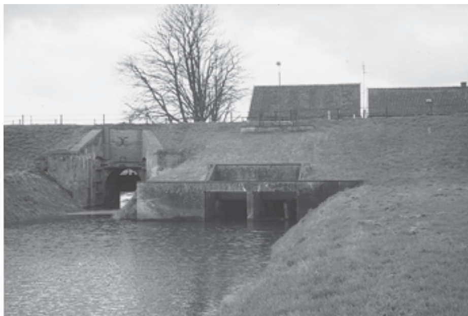
Afb. 3. De direkt naast Van Nispen's sluis gelegen uitwateringsbuizen van het stoomgemaal, 1998. (Foto: W. Wolters, Ede.)
