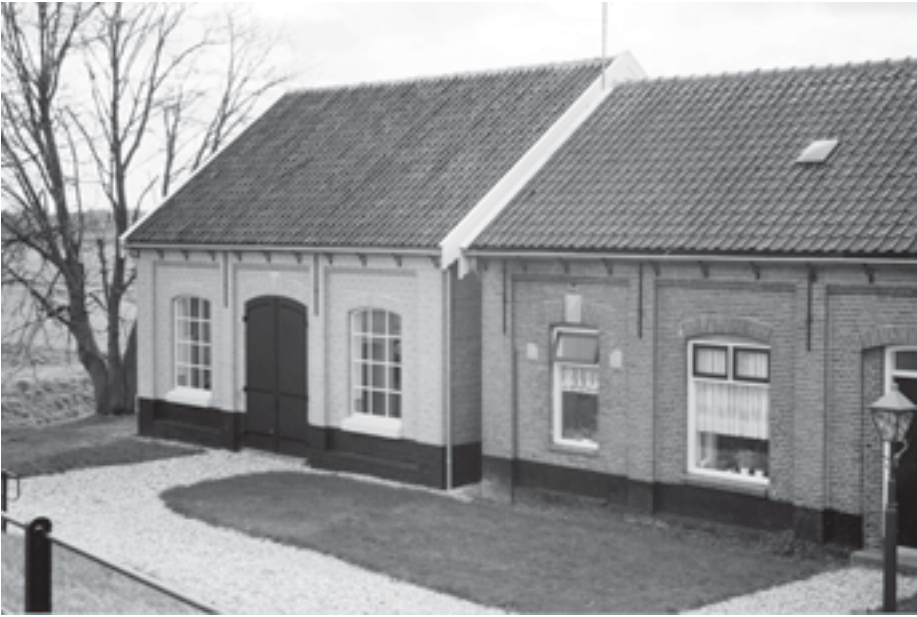
Afb. 6. Het gemaal na de restauratie in 1997. (Foto: W. Wolters, Ede.)
