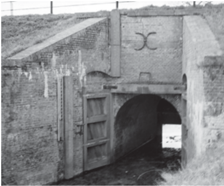
Afb. 2. De op voorstel van jhr. Van Nispen gebouwde grote sluis in de Aerditse dijk, 1998. (Foto: W. Wolters, Ede.)
