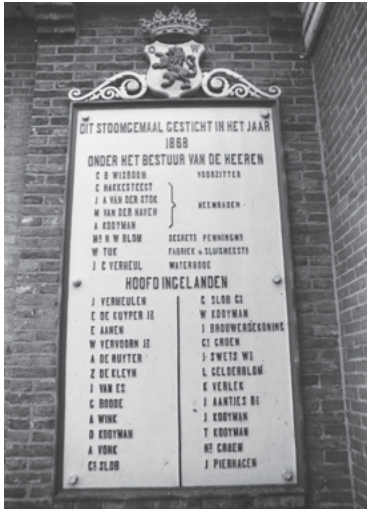
Afb. 3. De voorzijde van het Wisboomgemaal te Kinderdijk. (Foto: P. Nijhoff, Nieuwegein.)
