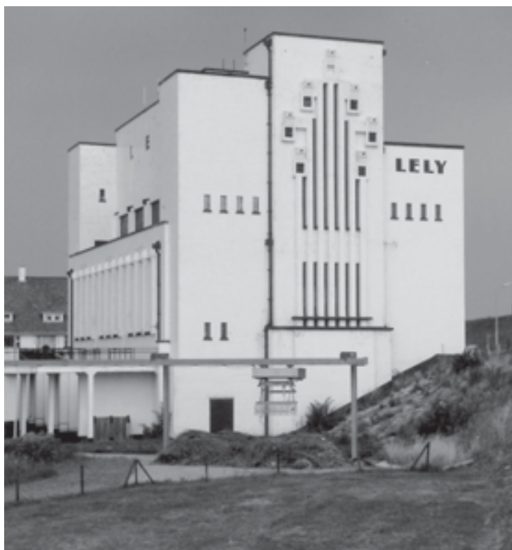
Afb. 2. Het ir. Lelygemaal te Medemblik. (Foto: P. Nijhoff, Nieuwegein.)
