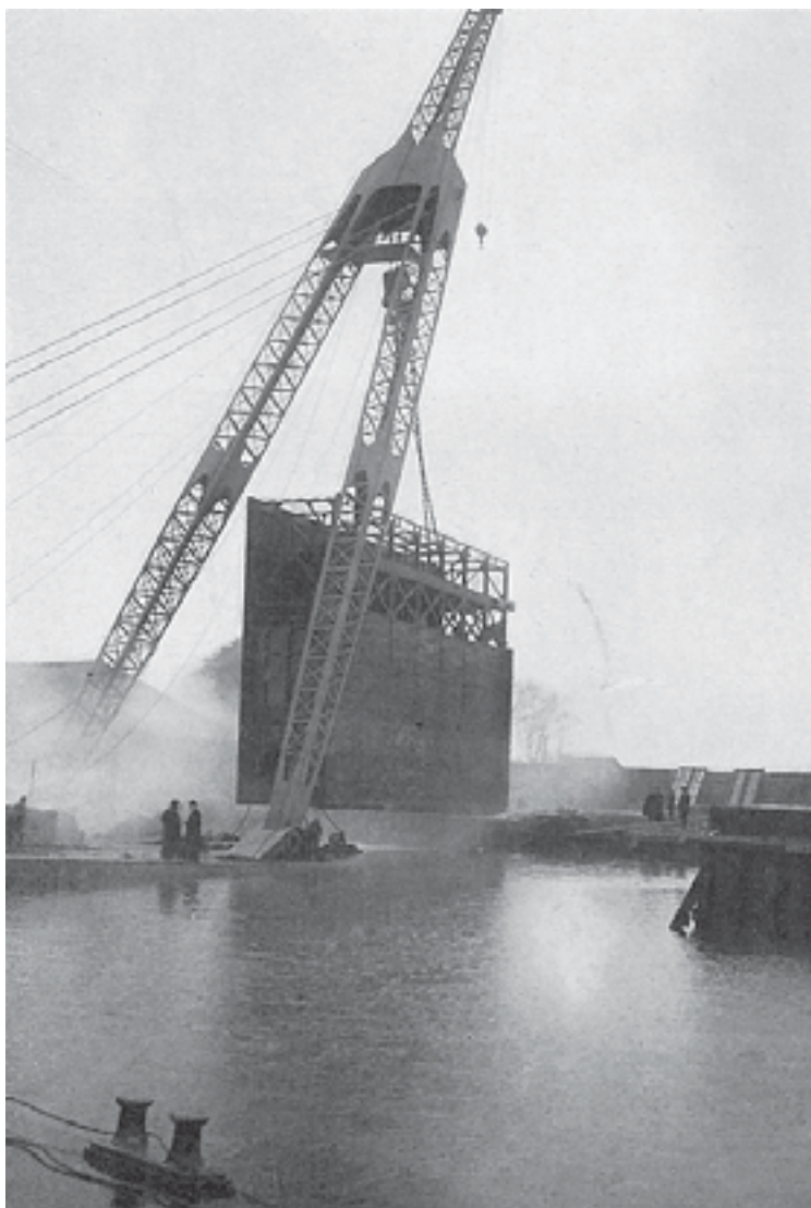
3. Het te water laten van de buitendeur van de derde schutsluis te Hansweert. Bron: Ringers, Beschrijving , fig. 38.
