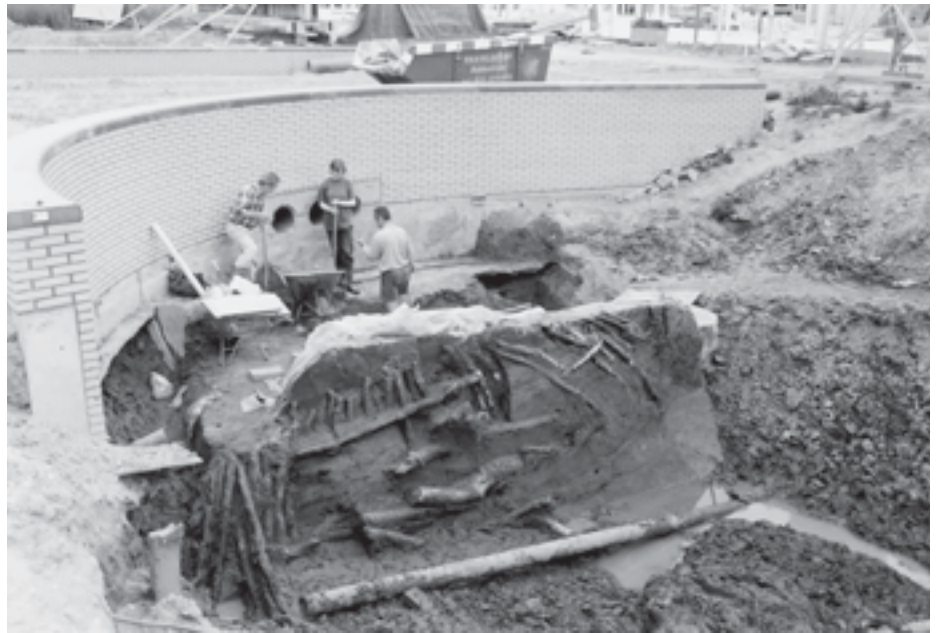
Afb. 5. 2000 jaar waterbouwkunde. Bij de aanleg van een moderne duikerbrug werd een prehistorische versie ontdekt. Hier is de zuidelijke beschoeiing zichtbaar. Locatie 6.36-D5 (foto: T. de Ridder, VLAK).
