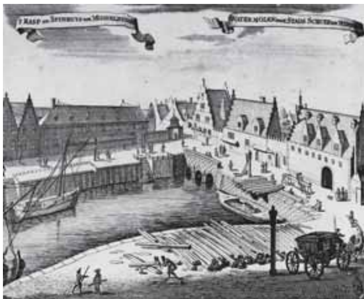
Afb. 5. Getijmolen bij de Stadsschuur/ Nieuwe Haven op een kopergravure eind zeventiende eeuw; rechts het maalgat en links de twee spuigaten. Uit: M. Smallegange, Cronyk van Zeeland (Middelburg 1696).
