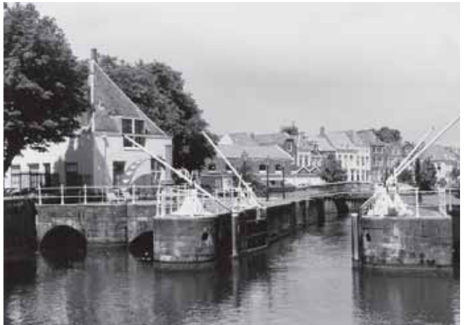
Afb. 8. Het gerestaureerde complex, gezien vanaf de Vlissingsebrug (landzijde). Het gebouw links is de voormalige getijmolen, rechts de schutsluis. Duidelijk is het maalgat (uiterst links) en de spuisluis (midden) te zien. Foto: W.Th. van der Veur.
