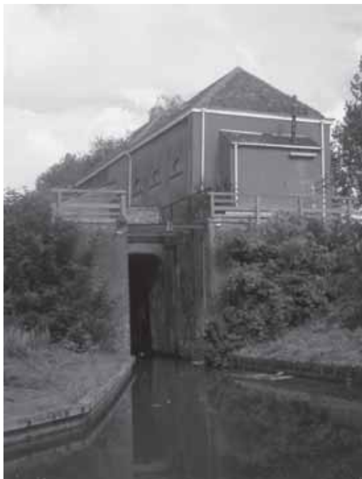
17. Het gemaal van de Polder van Nootdorp vanuit het westen. Enigszins zichtbaar zijn de schotbalkspinningen in de diepe inlaat van het gemaal. Volgens de machinist hebben er in de inlaat in het verleden keerdeurtjes gehangen.
