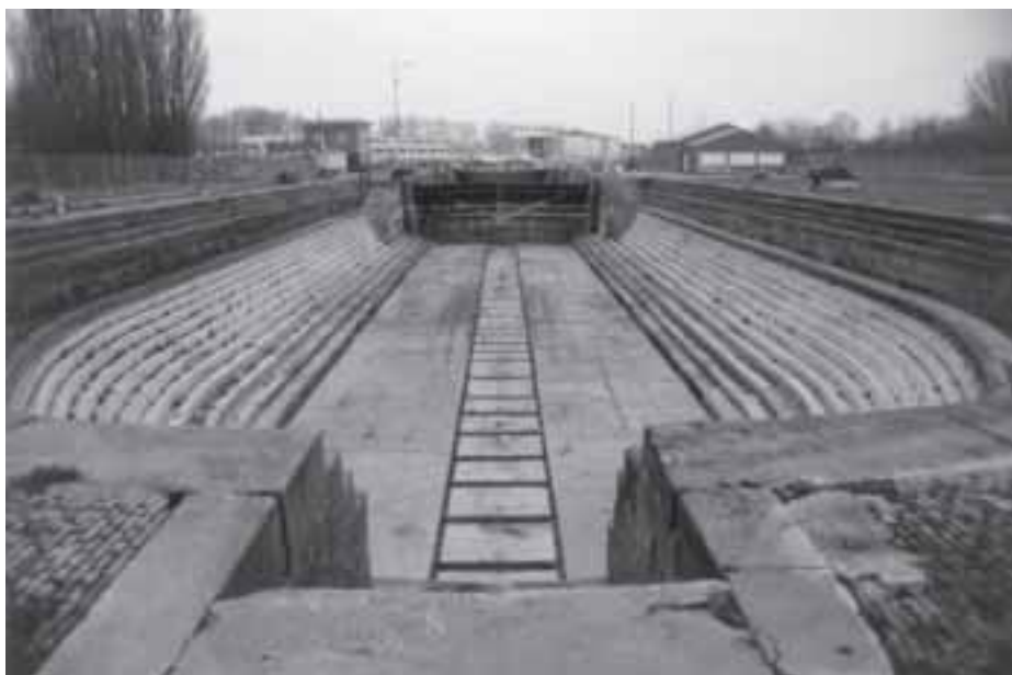
12. Het Timmerdok met op de achtergrond de metalen puntdeuren. Links en rechts is iets zichtbaar van de amfiteaterachtige beëindiging van het dok (foto: A.F.J. Niemeijer, 1998).
