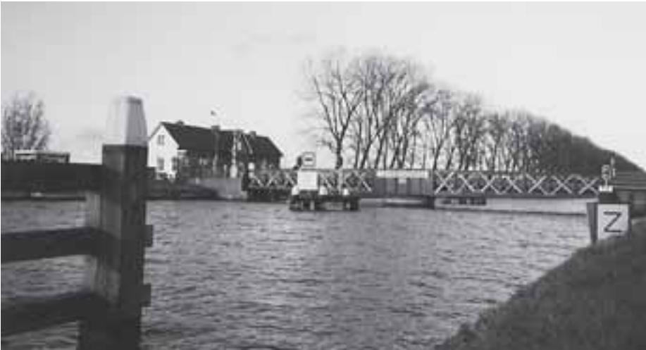
Afb. 6. De Zwaanskuikenbrug over het Merwedekanaal, halverwege Vianen en Meerkerk. Foto van de auteur.
