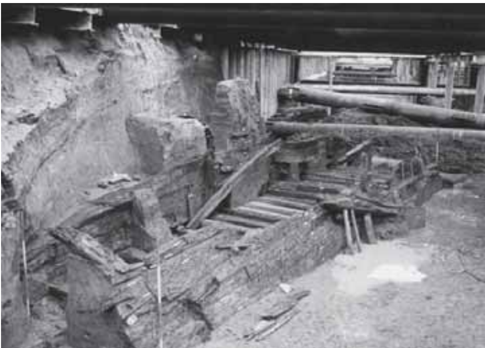
De restanten van de dertiende-eeuwse sluis tijdens de opgraving in het tracé van de Willemsspoortunnel in 1991. De wanden zijn gemaakt van hergebruikt scheepshout.
