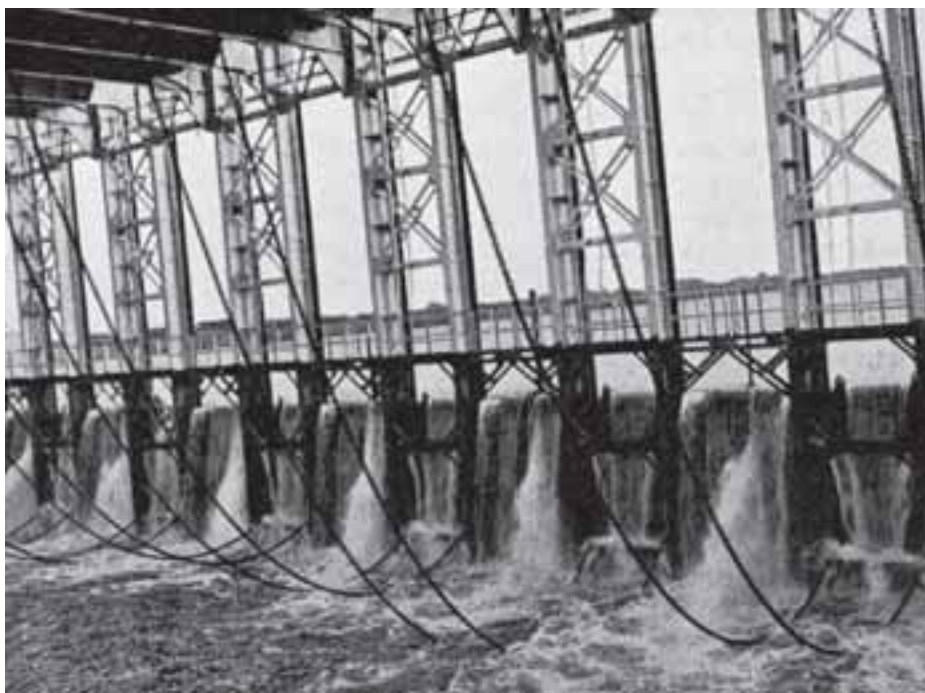
Een van de onderdelen van de Maasverbeteringswerken was de stuwbrug bij Grave, die in 1929 gereedkwam (uit: A.P. Potma, Weg- en Waterbouwkunde. Deel 3. Rivieren (Amsterdam 1942), 77).
