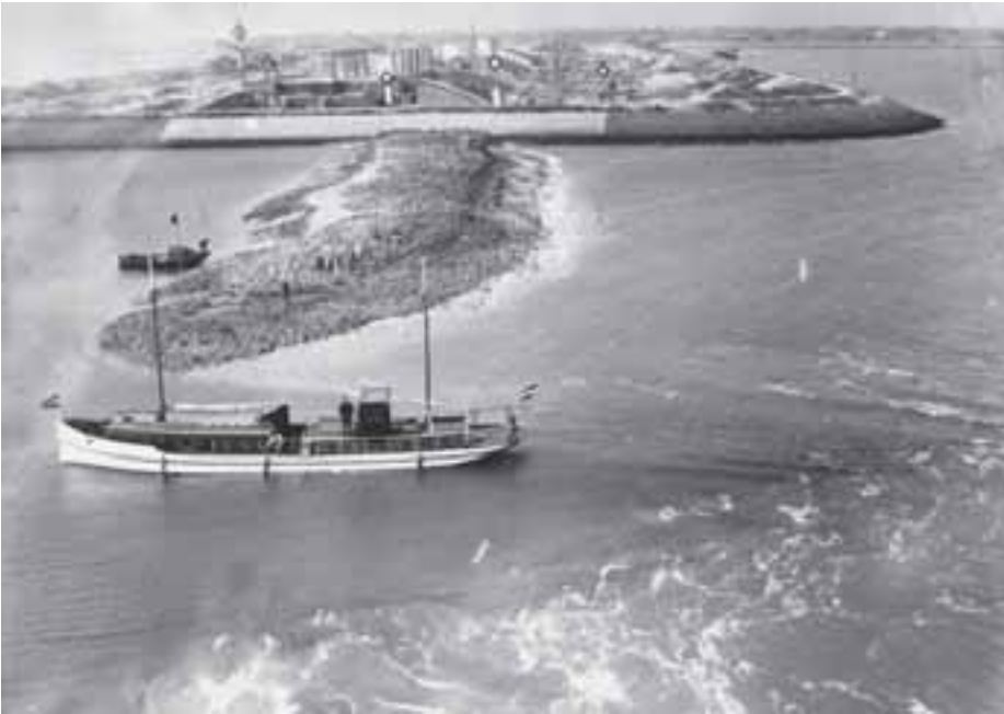
4. De stroomsnelheden in de geulen tussen de Waddeneilanden en tussen de delen van de afsluitdijk werden regelmatig gemeten, zo ook in het 'Gaatje'. Op de achtergrond is de bouwput van de sluizen bij Den Oever te zien. (Foto: Rijkswaterstaat, collectie Dienst Zuiderzeewerken).
