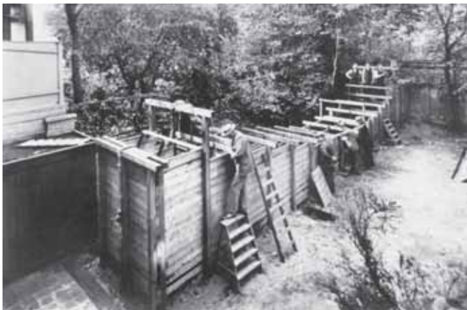
3. In de tuin van de Dienst der Zuiderzeewerken in de Zeestraat in Den Haag werd in 1919 een installatie gebouwd waarin golven konden worden opgewekt. Dit schaalmodel bood de mogelijkheid de golfloop te bestuderen. (Foto: Rijkswaterstaat, collectie Dienst Zuiderzeewerken).
