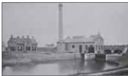
3. Het stoomgemaal te Waalwijk en de werken aan de benedenmond van het afwateringskanaal 's-Hertogenbosch-Drongelen (uit: Bongaerts, Scheiding van Maas en Waal , fig. 42).
