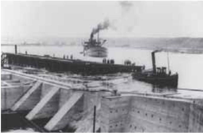
2. Een sleepboot brengt de deur van Noordersluis te IJmuiden (uit: Fotoboek Sluisbouw IJmuiden (Rijkswaterstaat, IJmuiden).
