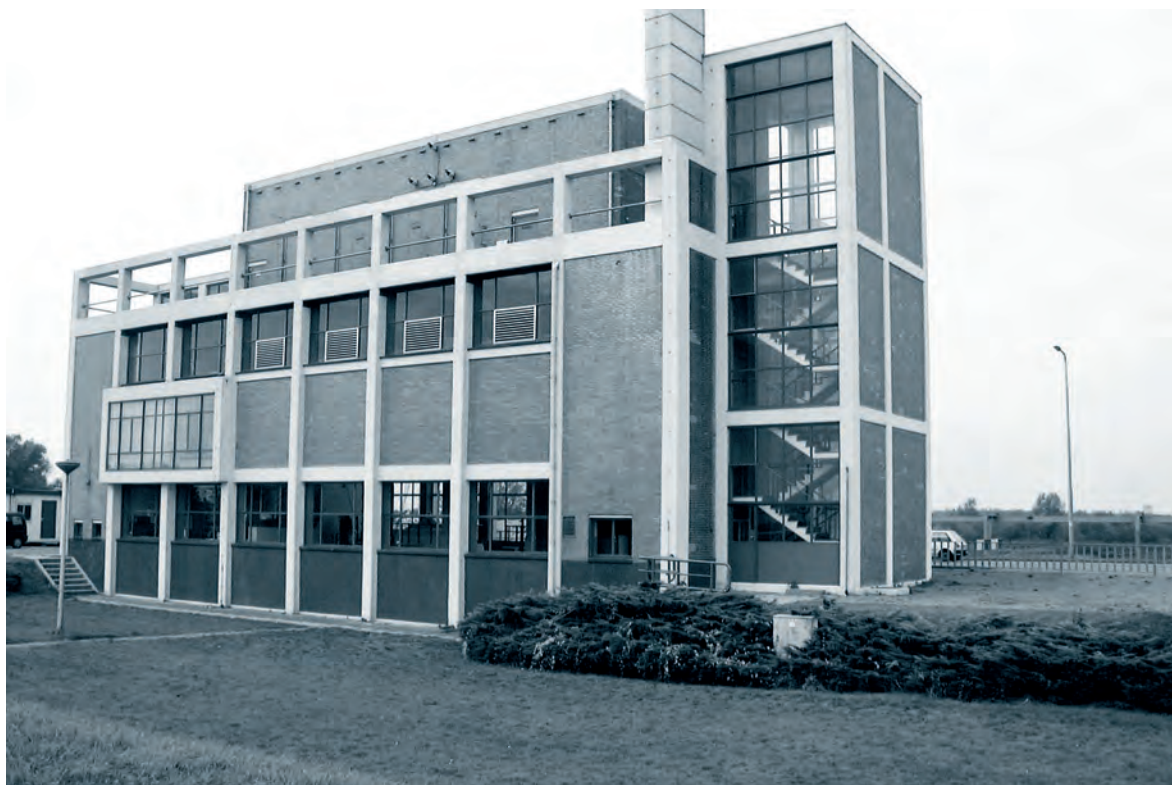
Het gemaal Lovink in de Flevopolder. Foto Waterschap Zuiderzeeland.
