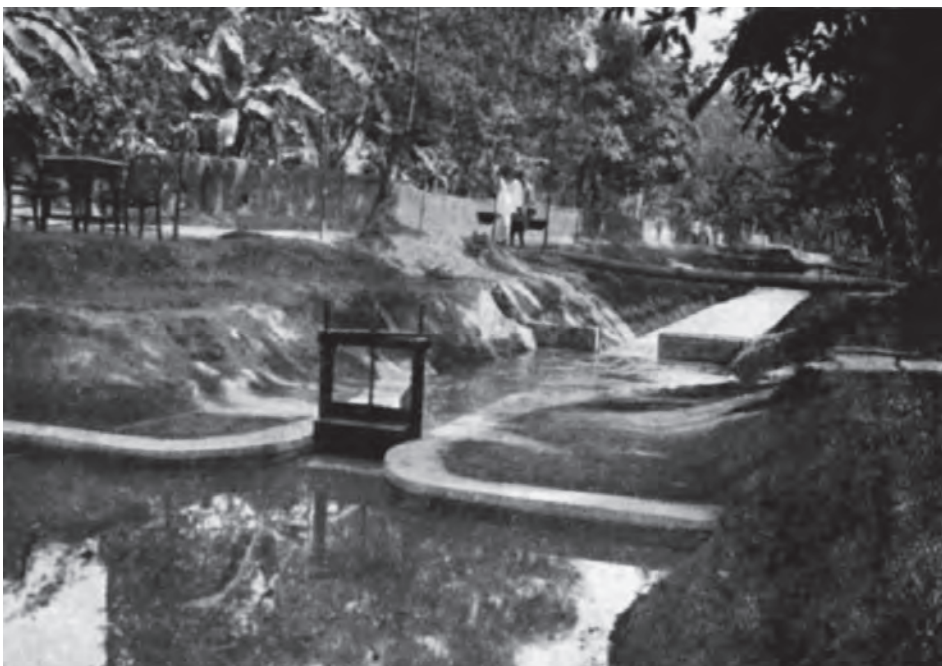
Afb. 1. Een koloniaal regelwerk. Overgenomen uit P. de Gruyter, 'Een nieuwe aftap- tevens meet-sluis en de resultaten van een proef met een dergelijk kunstwerk', De Waterstaatsingenieur 1 (1926), 1-15.
