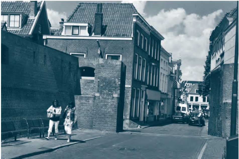
Afb. 6. Coupe in de stenendijk te Gorinchem, met gleuven voor het aanbrengen van hoogwatervoorzieningen. Foto auteur 2009.
