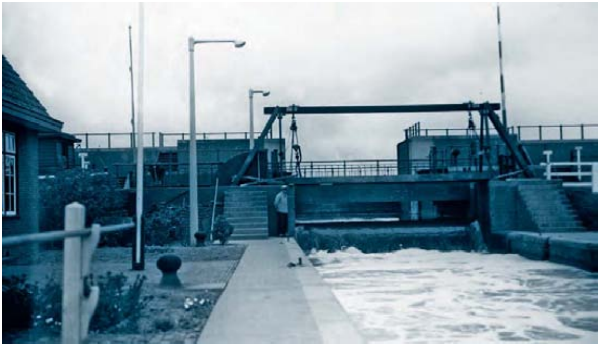
Afb. 10. De Overle- kersluis bij Medemblik waardoor water uit de Wieringermeer naar de Vier Noorder Koggen is afgelaten. Met de tij- delijke hijsconstructie kon door het aanbrengen of wegnemen van schotbalken het debiet worden gereguleerd. Collectie W. Verkerk, Zuiderzeemuseum, Enkhuizen.
