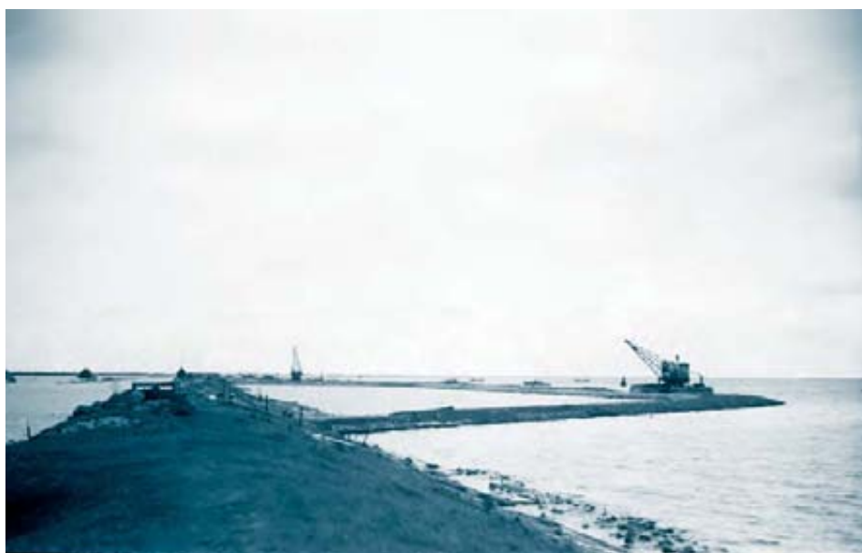
Afb. 8. Herstelwerkzaamheden in augustus 1945. De nieuwe dijk om de bresgaten is gesloten. Er kan begonnen worden met het leegpompen van de polder. Collectie W. Verkerk, Zuiderzeemuseum, Enkhuizen.
