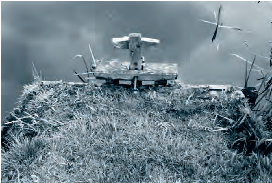
Afb. 2. Een 'pomp' aan de ringdijk van de Bergermeerpolder, dienende als inlaatsluisje. Foto auteur, 2010.
