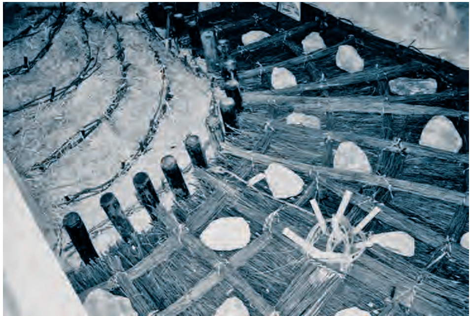
Afb. 5. Model van rijs-hout met steenbestorting in een dijktalud, getoond in het Watersnoodmuseum op Schouwen-Duiveland. Foto auteur, 2007.
