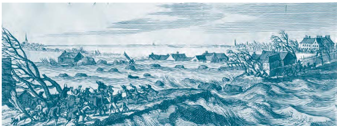
Afb. 1. Overstroming van 1675, doorbraak in de zuidelijke IJdijk. Huizen op duinen, dijken, huisterpen en op de polderbodem geven verschillende niveaus van bescherming. Bezit en foto: P. Van Dam.
