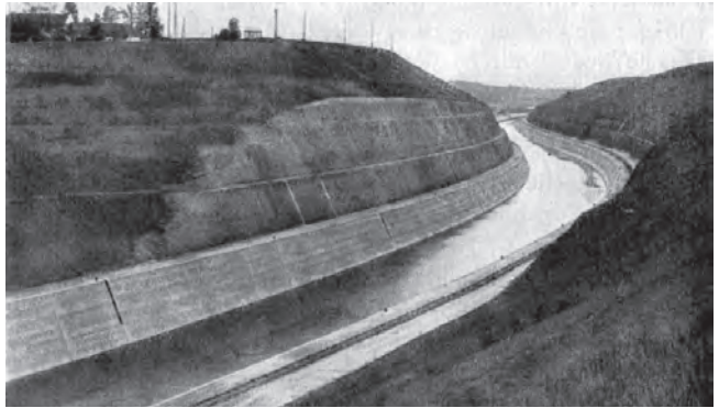
Afb. 11 Het Albertkanaal bij Vroenhoven. Per strekkende meter kanaal moest hier vijfduizend kubieke meter grond worden ontgraven. Delmer, Le Canal Albert , afb. 91.
