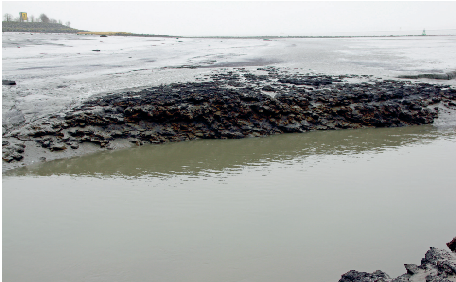
Afb. 2 Basis van een moerdijk in het Verdronken Land van Saeftinghe. Basisrestant is meer dan vijftien meter. Foto Adrie de Kraker, 2013.
