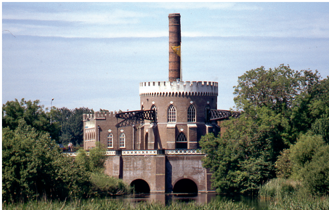
Afb. 1a-c De stoomgemalen Leeghwater, Lijnden en Cruquius waarmee het Haarlemmermeer is droog-gemaakt. Foto's Bart Schultz.
