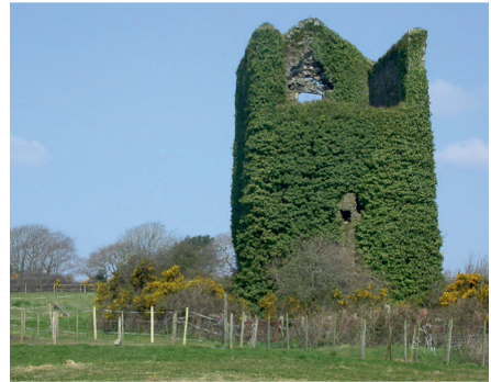
Afb. 10 Ruïne van Austen's engine shaft, Tywardreath and Par, Cornwall. Foto Peter Haas, April 2004.
