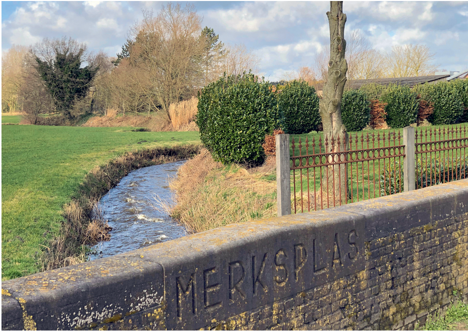
Afb. 5 De Mark was in Merksplas zelfs bij nat weer in 2020 slechts een brede sloot met stromend water. Foto Kajako-Hans Van der Borght.
